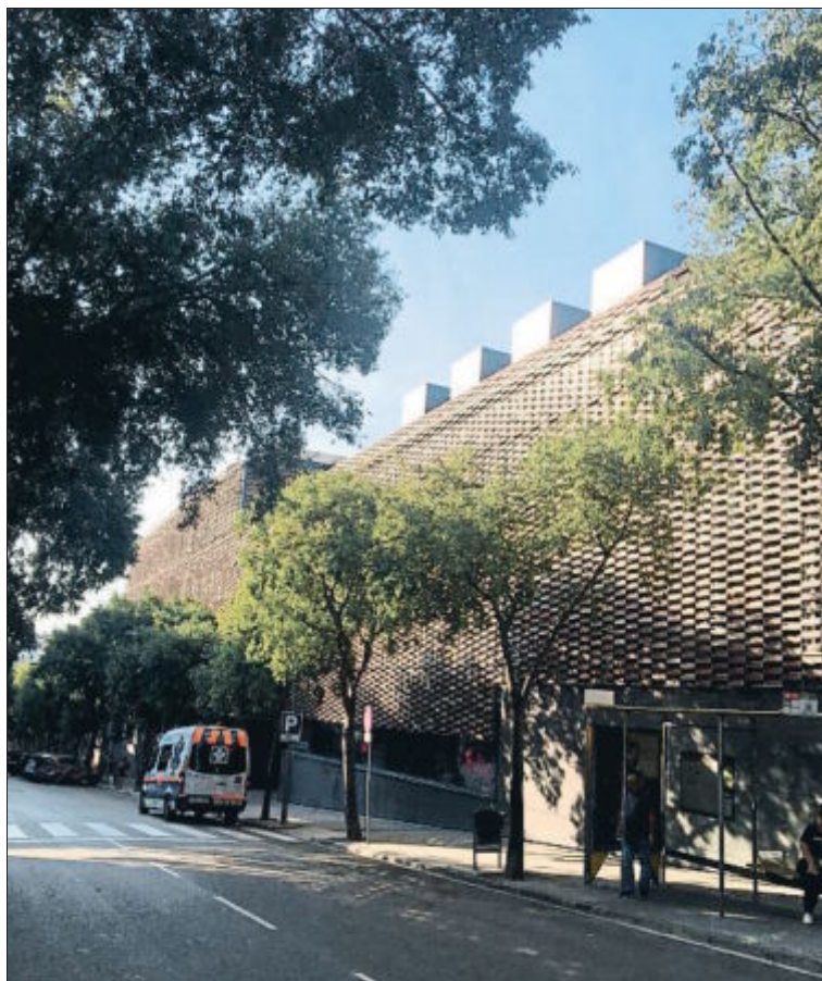
Façana de l'Institut de Recerca de l'hospital de la Santa Creu i Sant Pau
